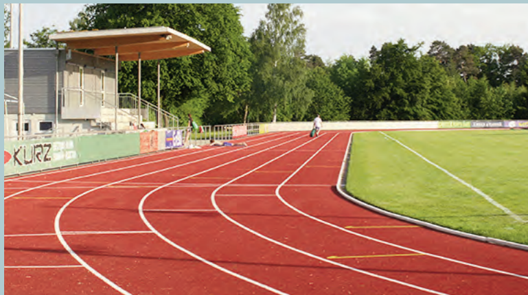
Errichtung Funktionsgebäude (Tribüne) 2009
